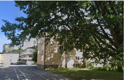
Bild visar de grener som bedöms förhindra den fria lyftzon som mekanisk avfallshantering kräver
