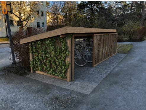
Bild visar en illustration över hur ett cykelhus kan utföras för att ge väderskydd och stölskydd av cyklar. Detta är ett exempel för att visa att cyklar kan placeras säkert och väderskyddat utan att ta i anspråk mer plats än vad befintliga cykelplatser redan gör. Utförs de i trä knyts de samman till befintlig pergola och ger ett enhetligt intryck. Bild visar ett hus med 6 st cykelplatser
